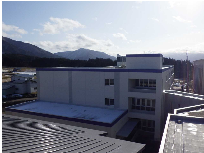
① 実習棟 大講堂 建設地（北側）
